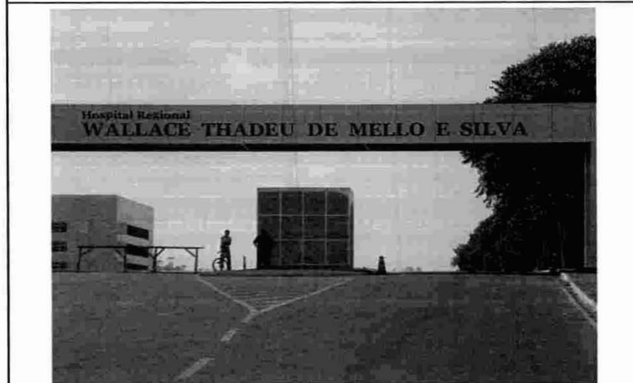
Foto 2 - Construção da Portaria de Acesso ao Hospital - Vista Frontal – 19/04/2010
