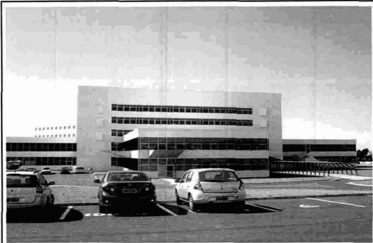
Foto 3 – Construção do Hospital Regional de Ponta Grossa - Vista Frontal – 19/04/2010
