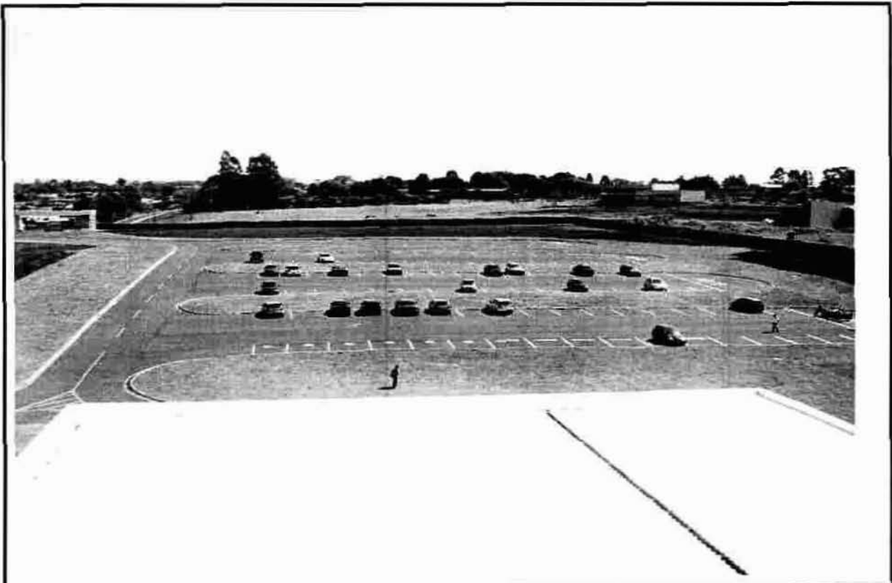
Foto 19 – Pavimentação Externa/Hospital Regional de Ponta Grossa – Vista Superior – 19/04/2010
