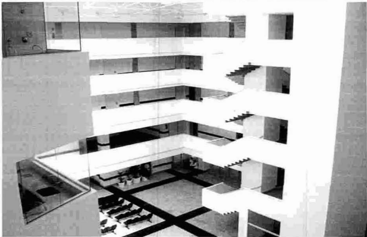
Foto 4 – Construção do Hospital Regional de Ponta Grossa – Vista Interna -19/04/2010
